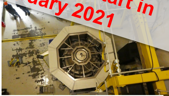
PE shielding installation
